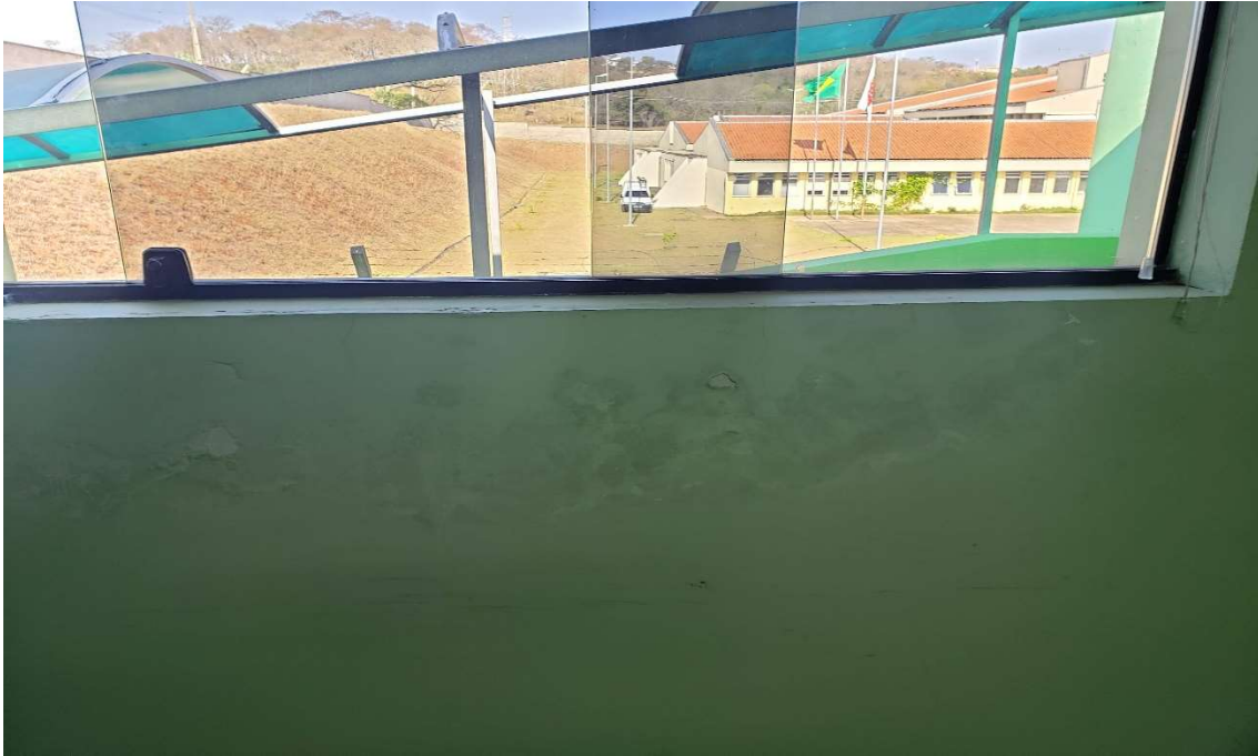
Foto 19 - Nesta imagem podemos notar que a maioria das esquadrias estão com problemas de vedação, pela falta de pingadeira do lado externo, como também, a má qualidade no serviço de vedação das mesmas.
