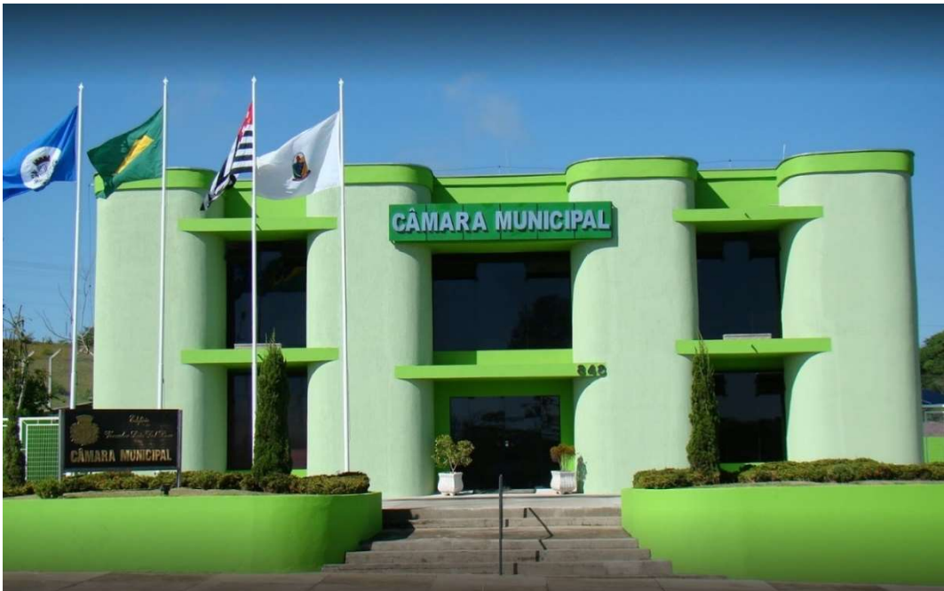
Figura 1 - Imagem da fachada do imóvel.
