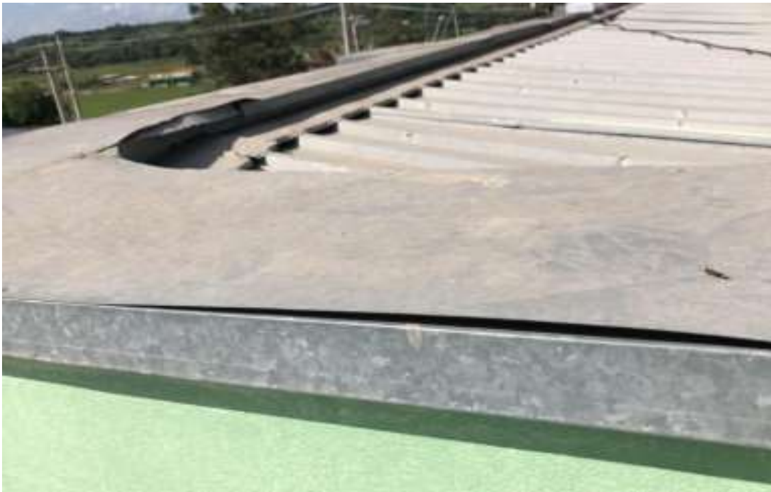
Foto 27 - Nesta imagem podemos notar que as pingadeira e rufos, além de tortos, também apresentam pontos sem fixação e vedação'.
