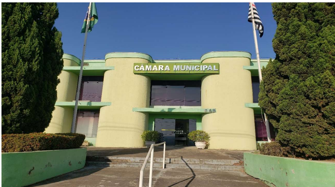
Foto 1 – Nesta imagem podemos notar que o prédio não apresenta nenhuma avaria na edificação, apenas a necessidade de pintura externa para proteção e estética. Também podemos notar algumas trincas e umidade na estrutura de contenção do jardim frontal.
